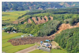
9月 北海道胆振東部地震 大規模な土砂崩れ 北海道全域で大規模停電
